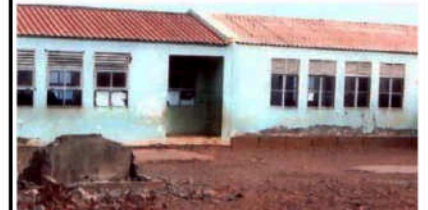
Upprustning av skolan i Preguiça under 2011-12.
